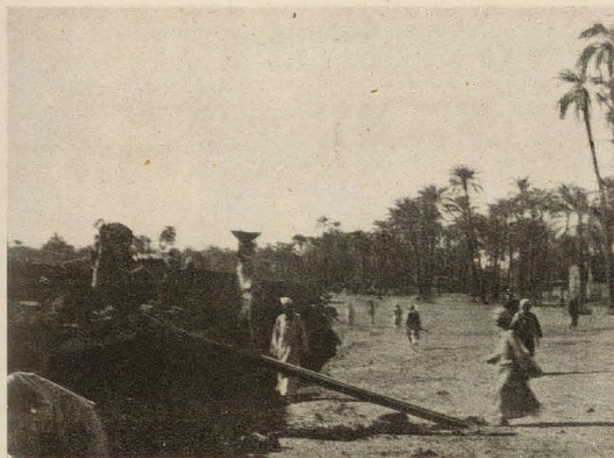
b) Construction du mur d'enceinte ouest.
